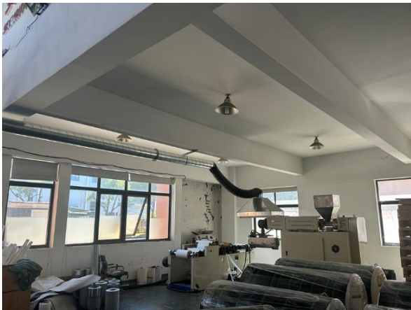
生产车间 1 小试废气集气罩收集
