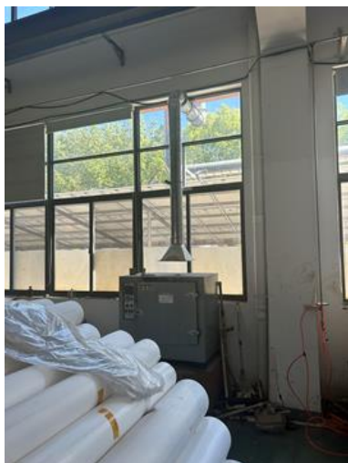
生产车间 1 烘干废气集气罩收集
