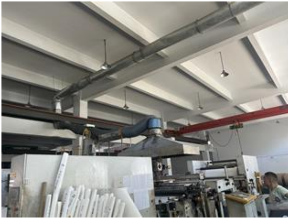
生产车间 1 淋膜废气集气罩收集
