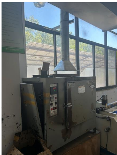
生产车间 1 烘干废气集气罩收集
