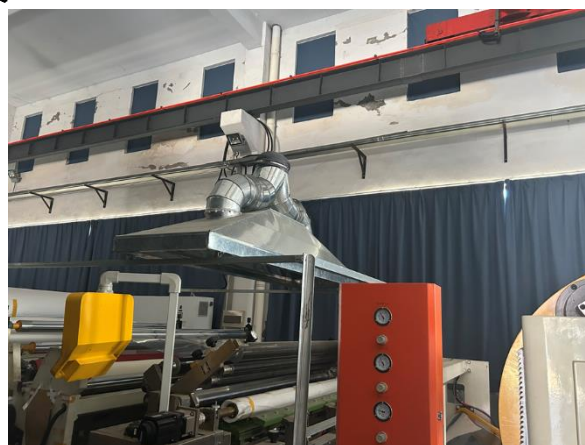
生产车间 2 UV 固化废气集气罩收集
