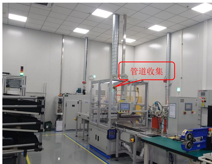
灌胶固化废气收集后输送至生产车间外无组织排放 图 4-3 企业废气治理设施照片
