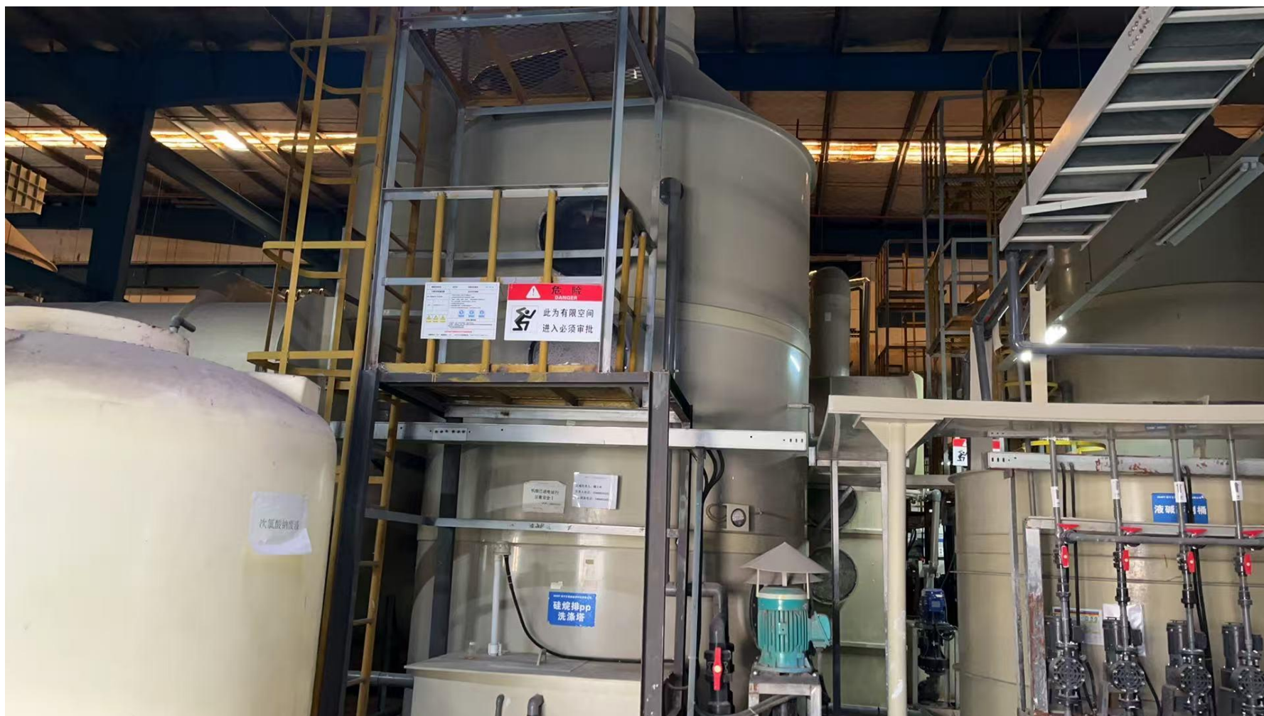
图 4-7 FQ009 燃烧桶+一级燃烧塔+二级洗涤塔设备
