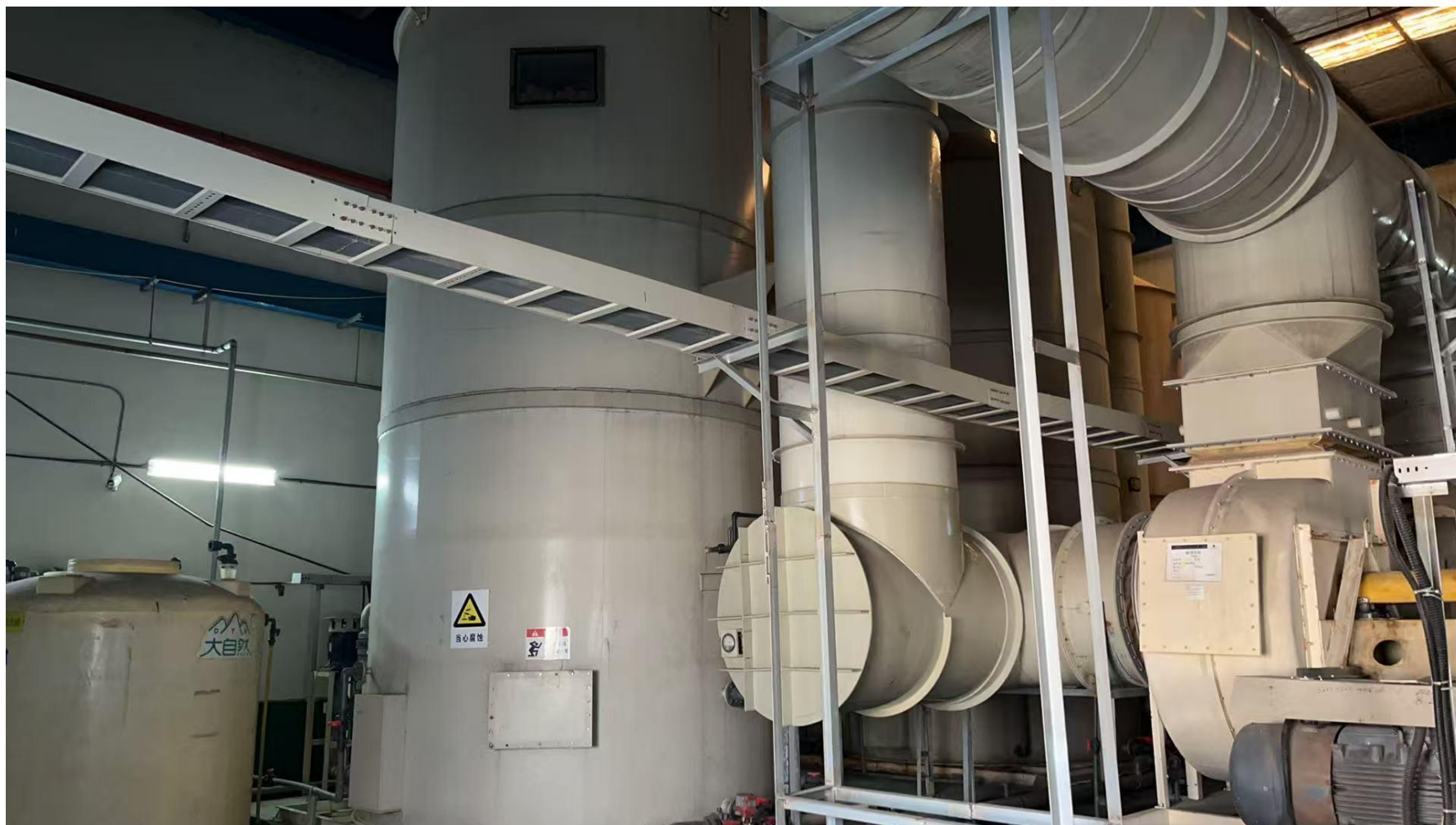
图 4-5 FQ007 三级碱喷淋串联洗涤设备
