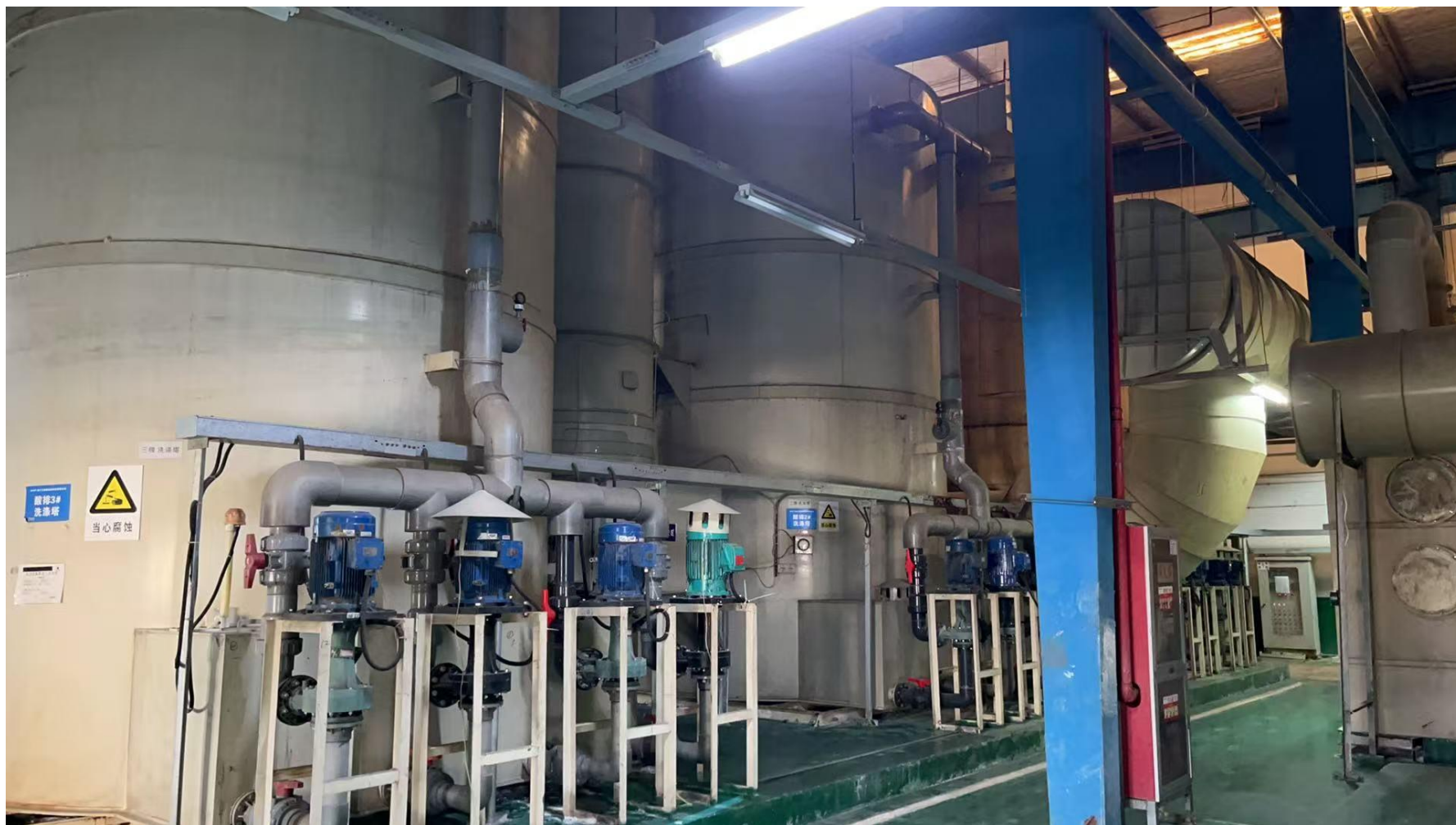
图 4-6 FQ008 三级碱喷淋串联洗涤设备
