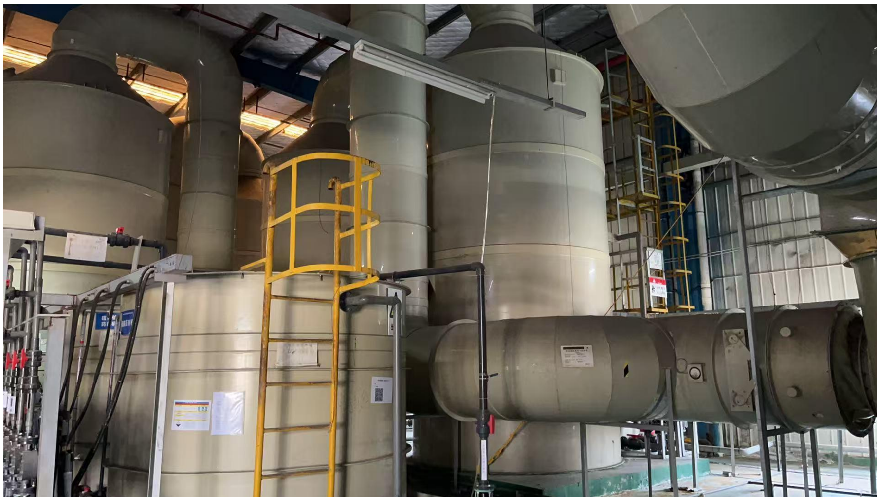
图 4-4 FQ006 三级碱喷淋串联洗涤设备
