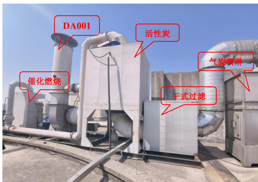
气旋喷淋+干式过滤+活性炭吸附浓缩+脱附催化燃烧
