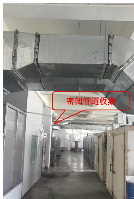
气旋喷淋+干式过滤+活性炭吸附浓缩+脱附催化燃烧
