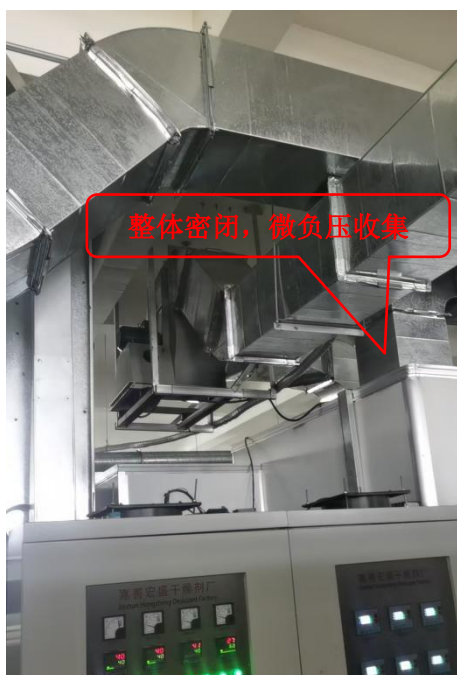
气旋喷淋+干式过滤+活性炭吸附浓缩+脱附催化燃烧
