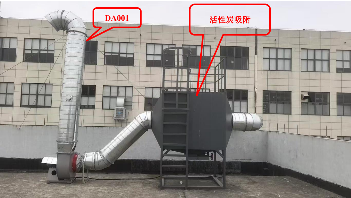
图 4-2 注塑废气“活性炭吸附”处理装置
