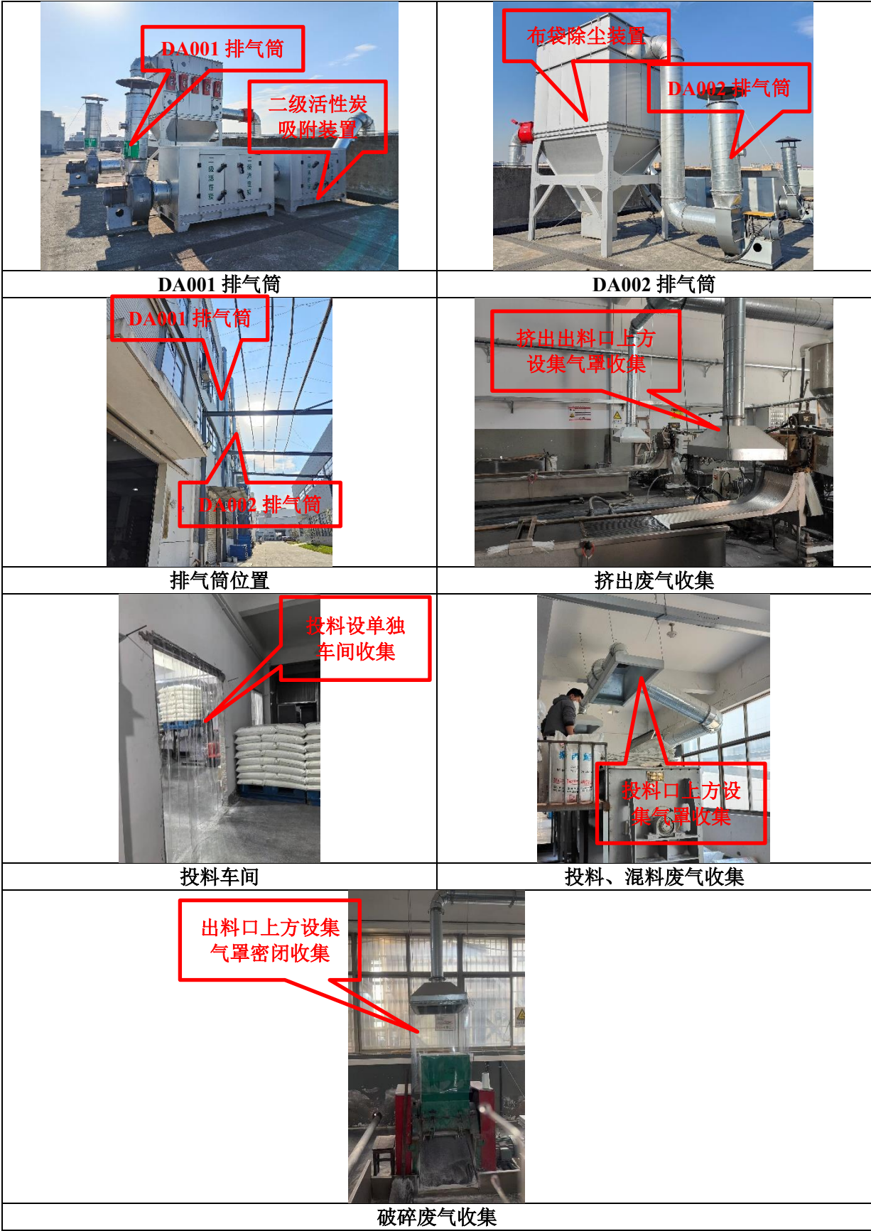
图 4-2 企业废气治理设施照片
