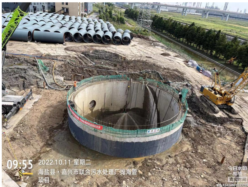
图 3.2-3 高位井施工照片 2
