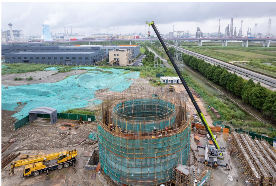
图 5.1-4 施工现场防尘布、遮盖物等措施
