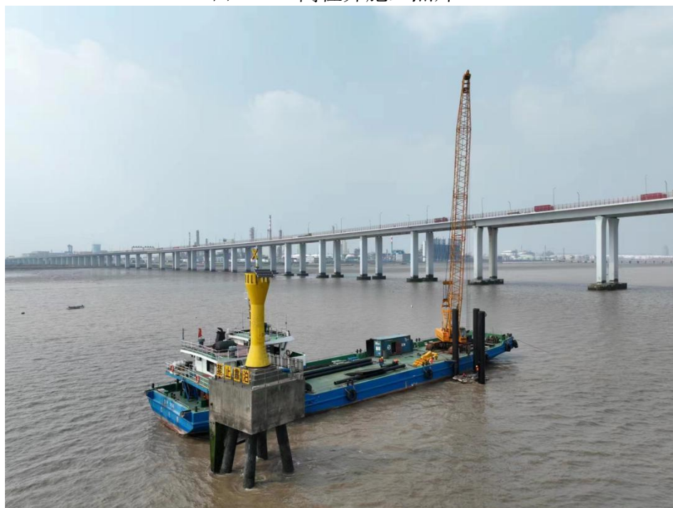
图 3.2-4 水上警示标志施工照片
