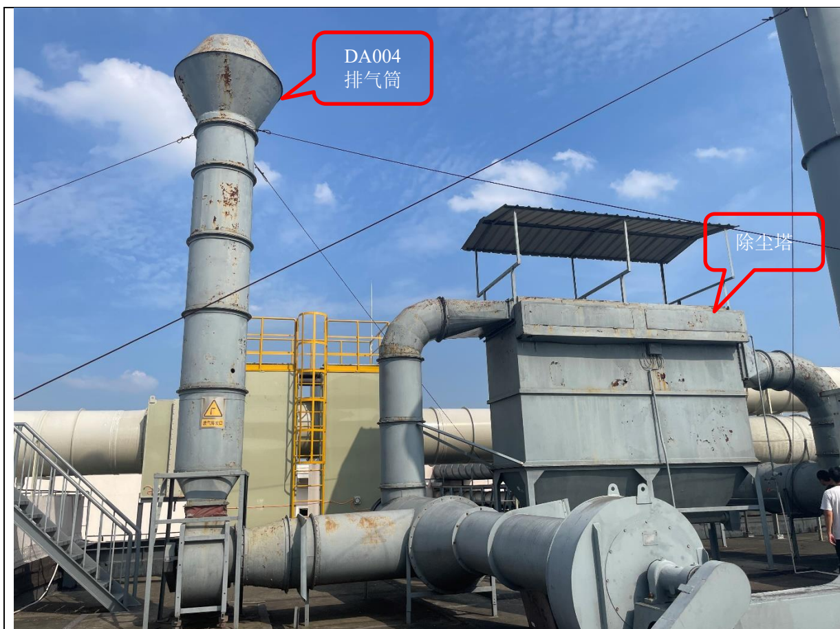
IC 封装“布袋除尘”装置
