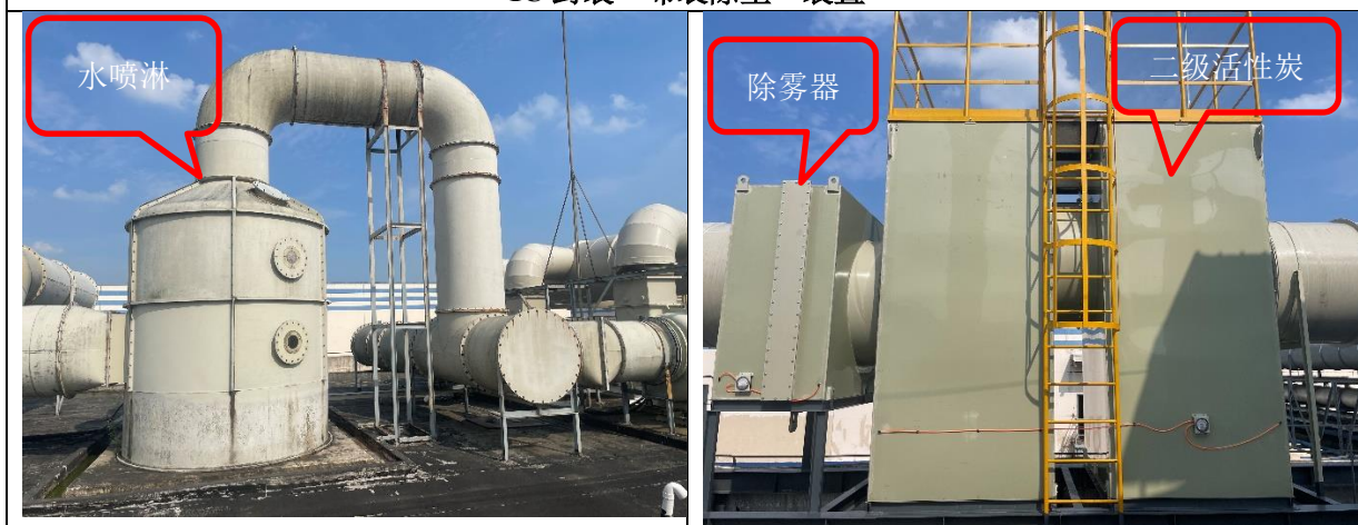
MICRO 封装“水喷淋+除雾器+二级活性炭”装置
