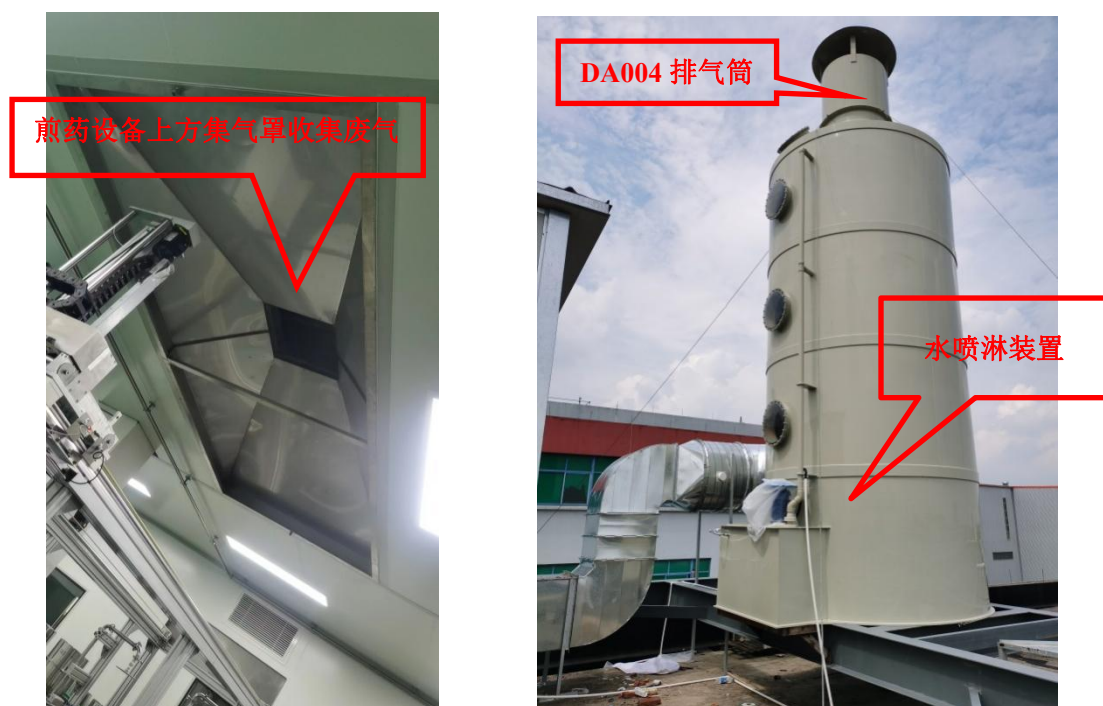
图 4-3 企业废气治理设施照片
