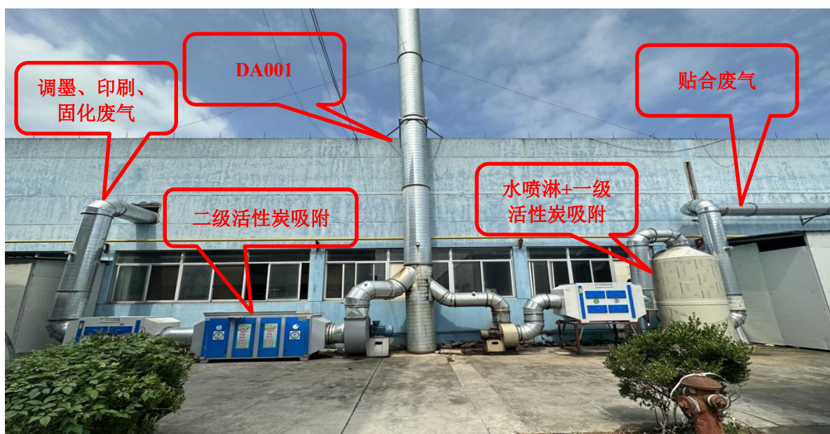
图 4-3 调墨、印刷、烘干废气“二级活性炭吸附”和贴合废气“水喷淋+以及活性炭吸附”废气处理装置
