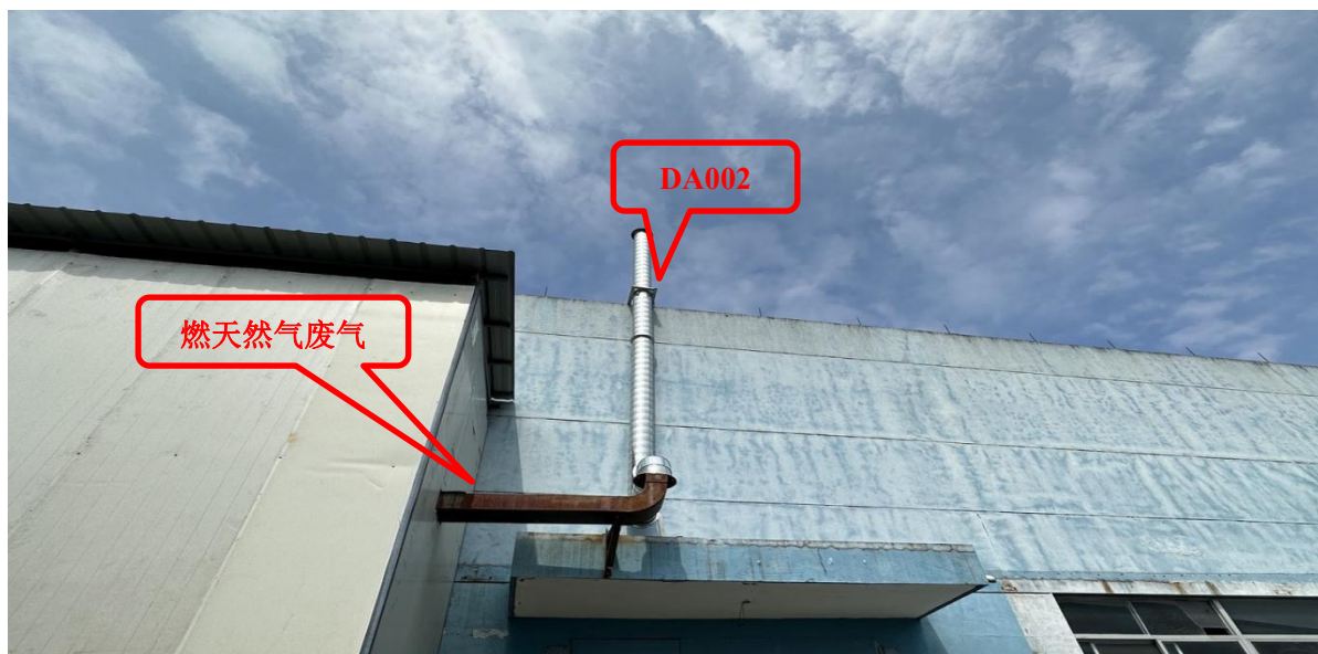
图 4-4 燃天然气废气排气筒
