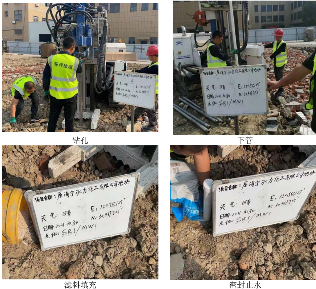
图 5.3-7 地下水采样井建井照片
