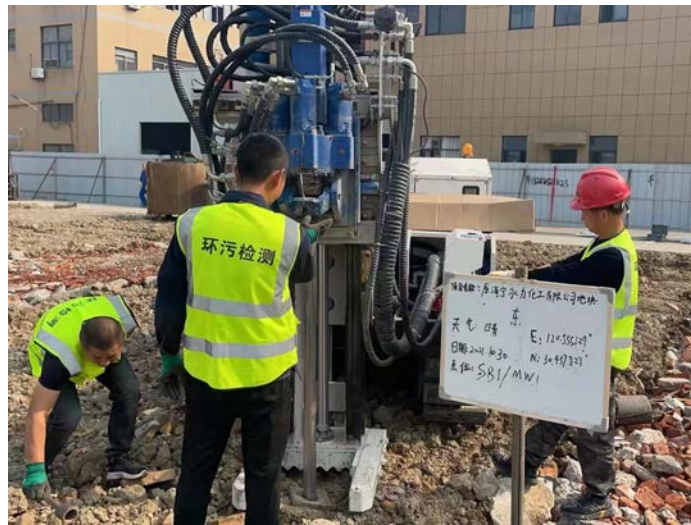
图 5.3-1 钻探设备
